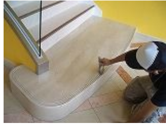
施工面の清掃
