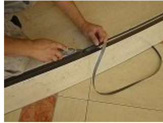
Kテープの施工
